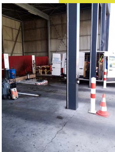
Pose de nouveaux blocs barrières (centre de transfert de Touques)
