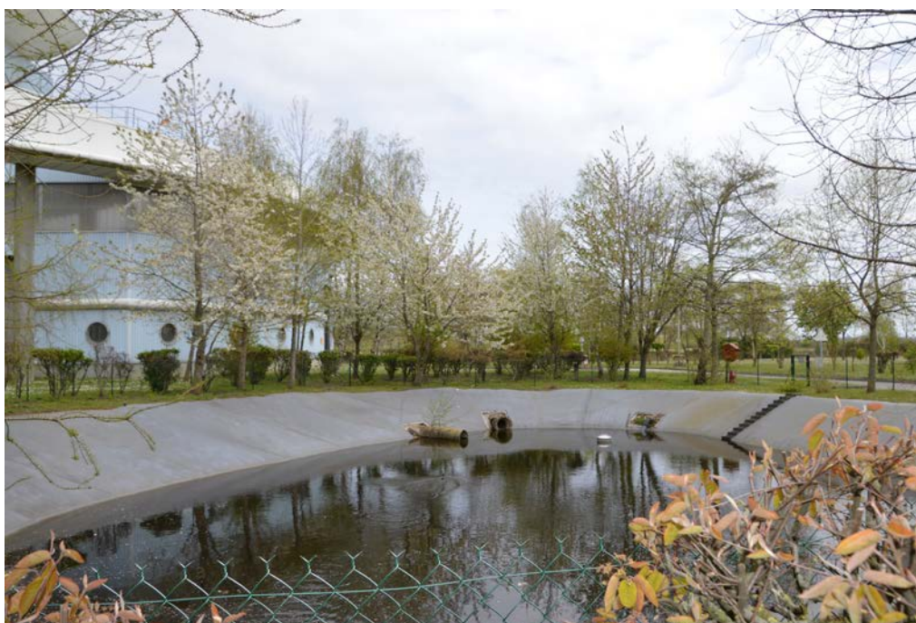
Bassin de l'UVE
