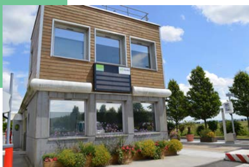
Le poste de pesage à l'entrée de l'UVE ECOSTU'AIR
