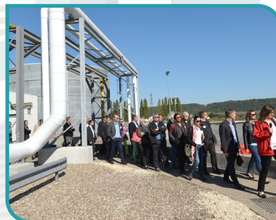
Réseau de vapeur
