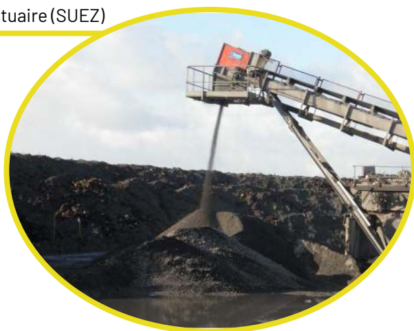
Mâchefers en sortie de four, après refroidissement
