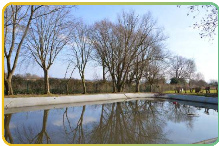
Bassin de l'UVE
